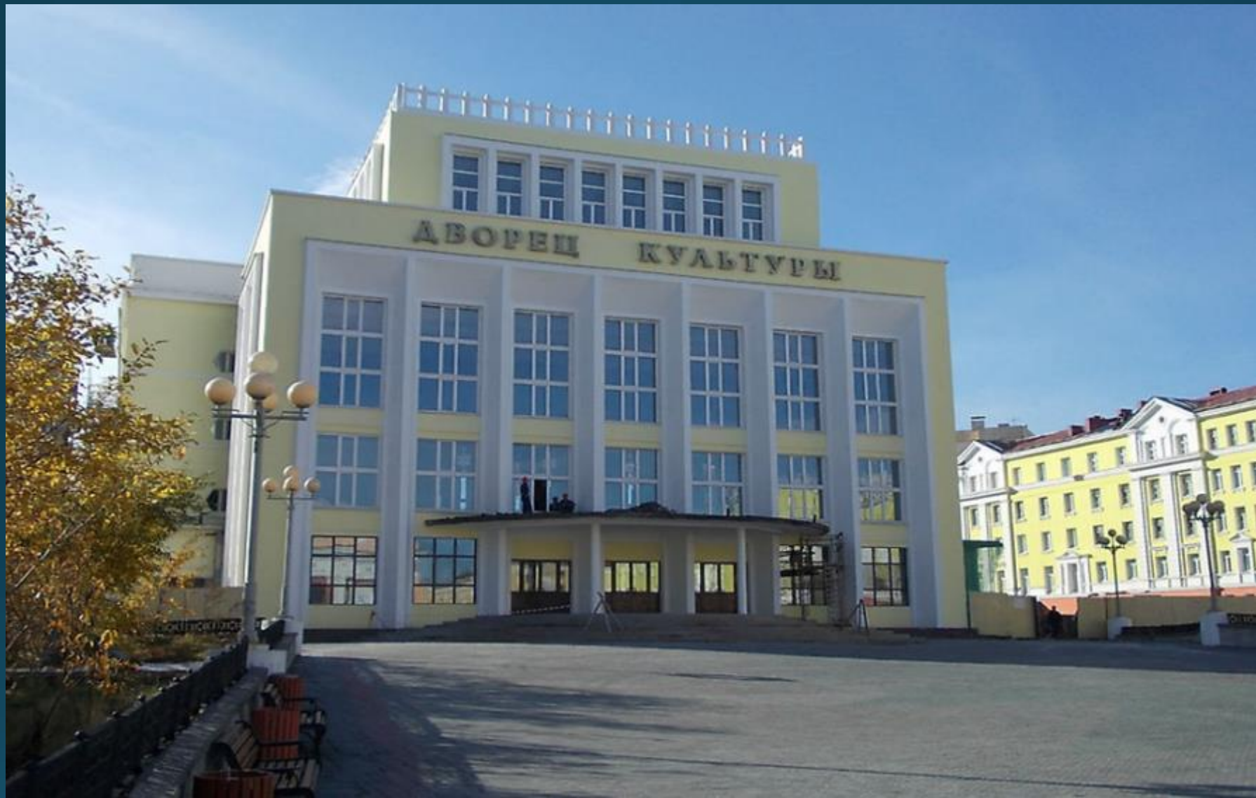
Дворец культуры металлургического комбината
